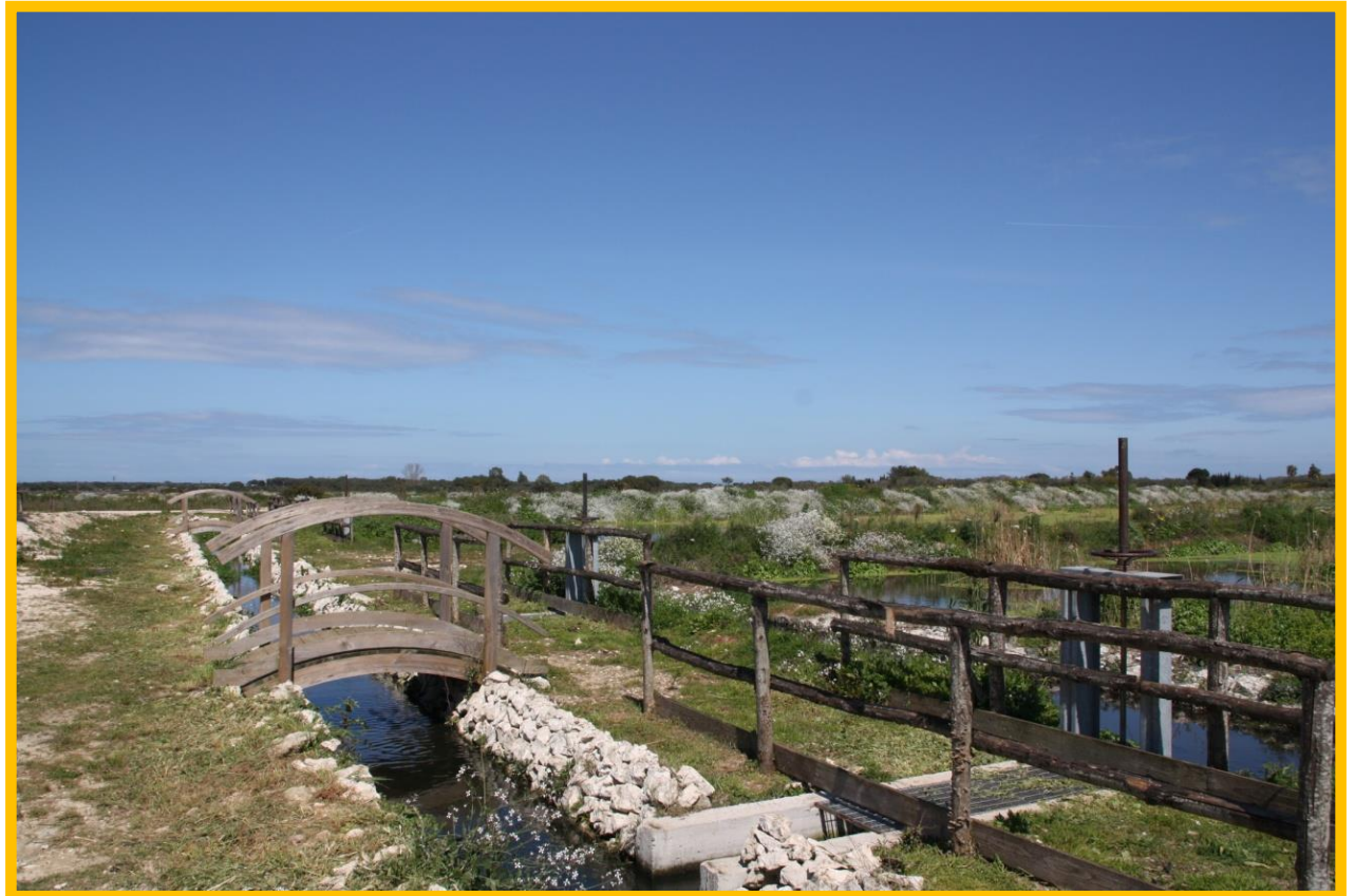
Canale di alimentazione del fitodepuratore dall'impianto a FA
