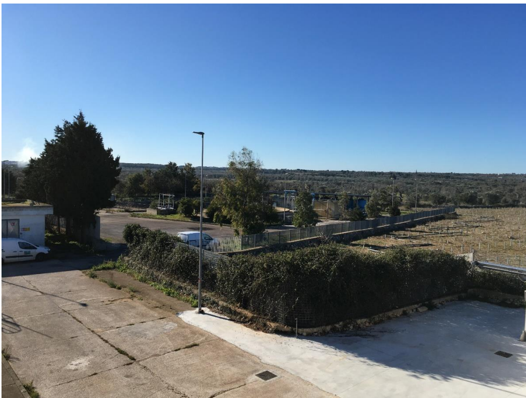
1. Vista impianto affinamento
