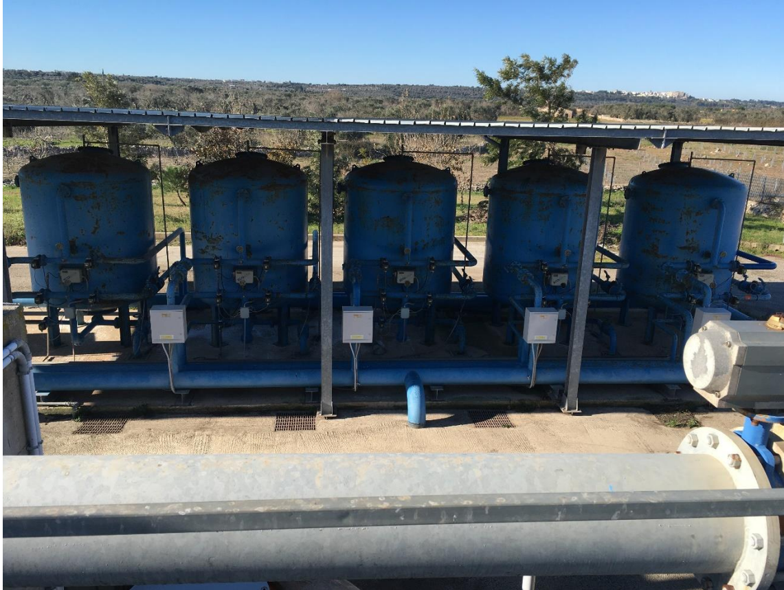
7. filtrazione rapida a pressione con sabbia di quarzite monogranulare
